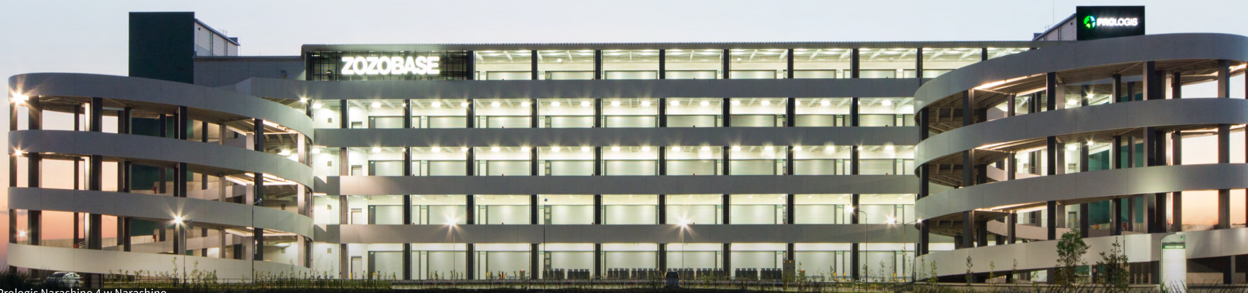
Park logistyczny Prologis Narashino 4 w Narashino w prefekturze Chiba w Japonii.
